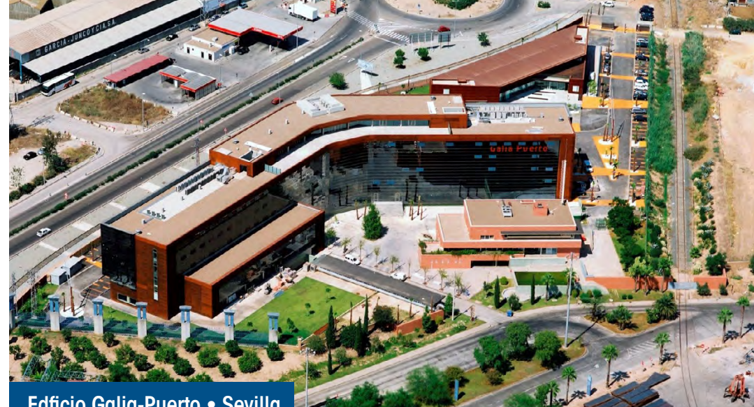
Edificio Galia-Puerto • Sevilla
